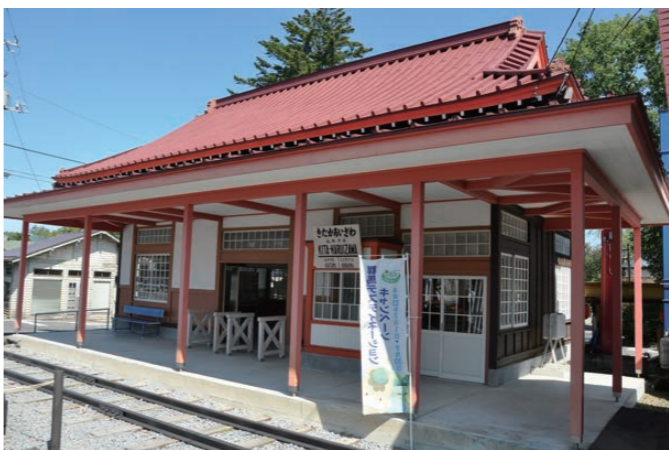
▶当時の姿のまま残されている「北軽井沢」駅舎。2006年の改修工事で鮮やかな色も再現された。
